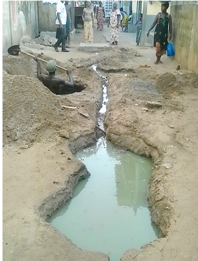
1. Vidangeur manuel faisant un trou pour y stocker les eaux vannes venant d'un regard bouché. Cliché: Oboué, mars 2016
