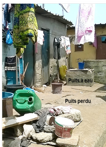
2. Puits perdu aménagé à moins de 5 m d'un puits à eau au quartier Adjouffou. Cliché: Oboué, mai 2016
